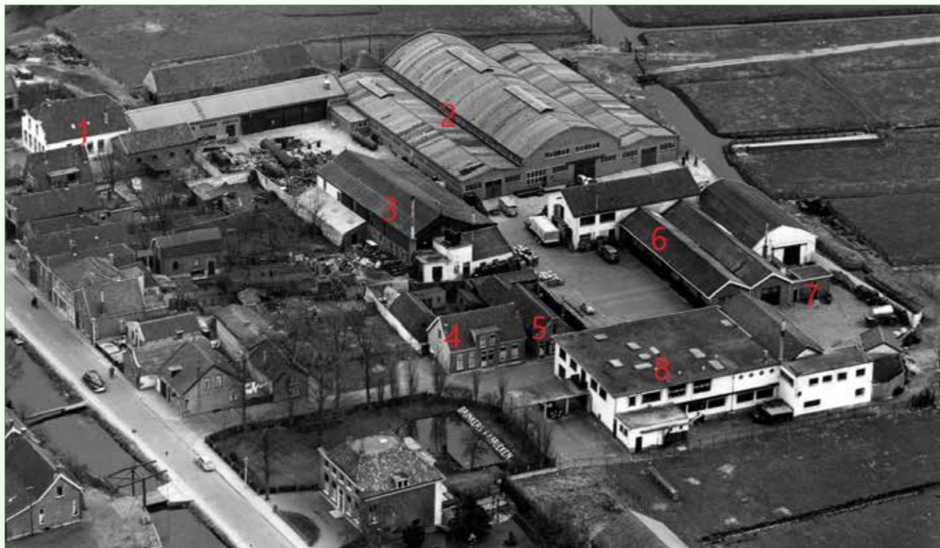
Brinkers fabrieken aan de Vlamingstraat rond 1960. 1. Voormalige boerderij Van Reeuwijk; 2. Hardglasfabriek; 3. Precisie Draaibanken Fabriek; 4-5. Woningen aan de Laan van Brinkers; 6; Autowerkplaats; 7. Transformatorhuisje; 8. Kantoor en drukkerij (foto Aerocarto)
