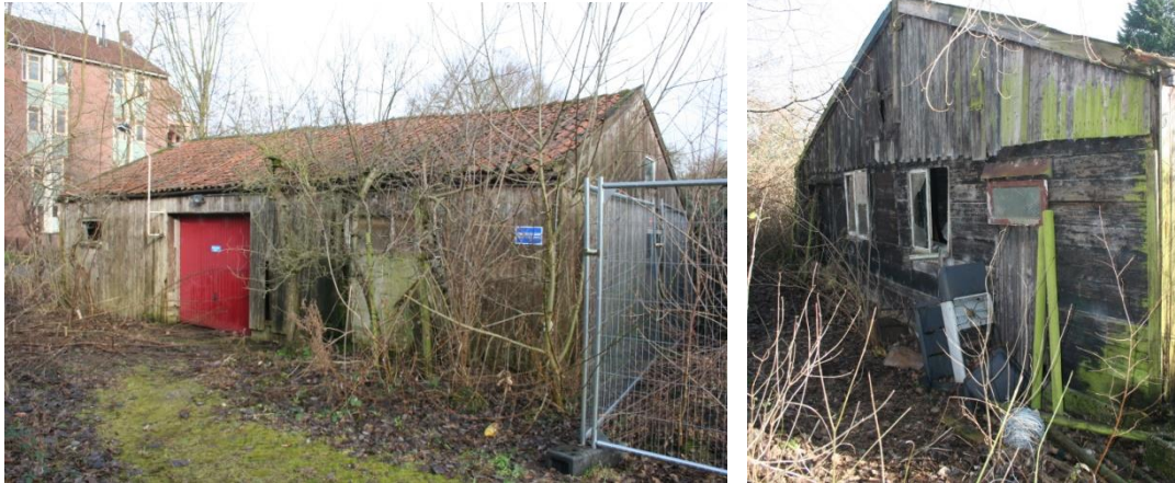
Figuur 19 Links de zuidgevel van bijgebouw 1, rechts de westgevel.
