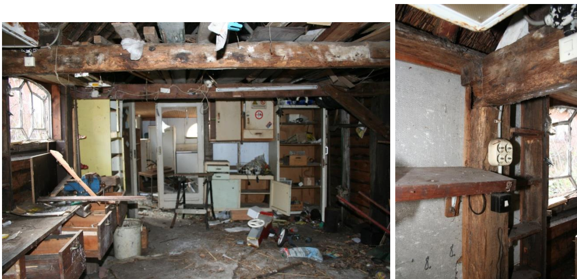
Figuur 22 Links: overzicht in zuidelijke richting, rechts: detailopname gebint constructie.
