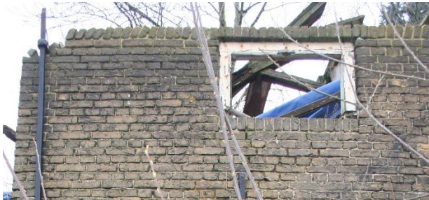
Figuur 10 Op de foto links is de stroomlaag die de zuidgevel afsluit zichtbaar. Het hooiluik is primair met het metselwerk aangebracht. Rechts de beëindiging van de zuidgevel, voorzien van vlechtingen.
