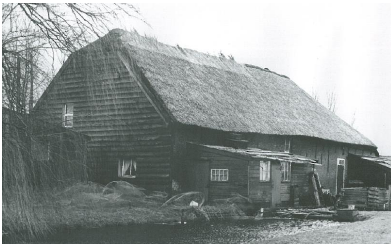
Figuur 3 Opname van de noordgevel. (Bron: Van den Burg, 2016)
