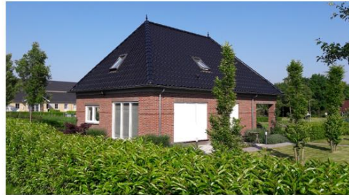
Na 2000, sobere dakverdieping
