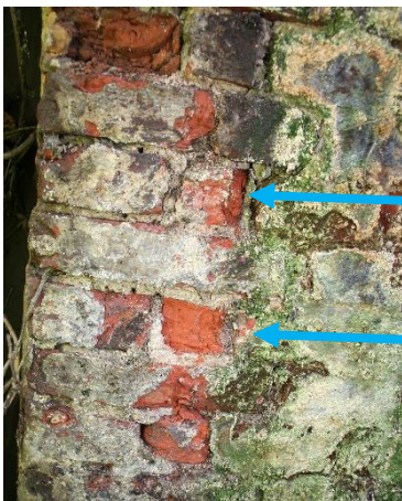
Figuur 13 Enkele van de klezoren op de hoek van de noord- en oostgevel.
