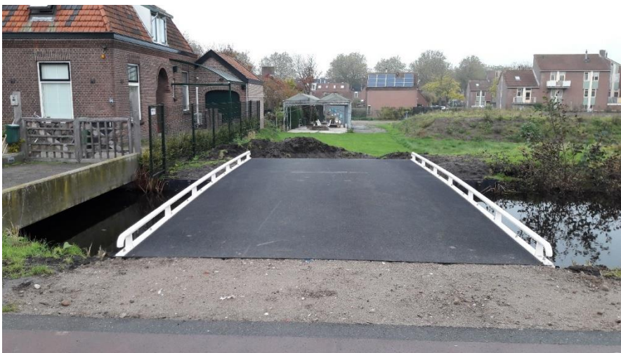
Brug naar no. 94B
