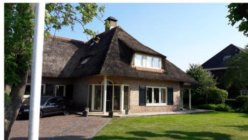
Na 2000, erg veel dak en dakkapel
