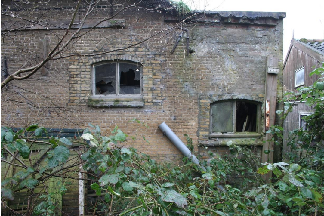
Figuur 12 De verstoorde noordgevel, nabij de westgevel. Aan het verstoorde muurwerk rondom om de vensters is te zien dat deze niet oorspronkelijk zijn en dat de gevel nabij de westgevel iets werd verhoogd ten behoeve van een uitbouw.
