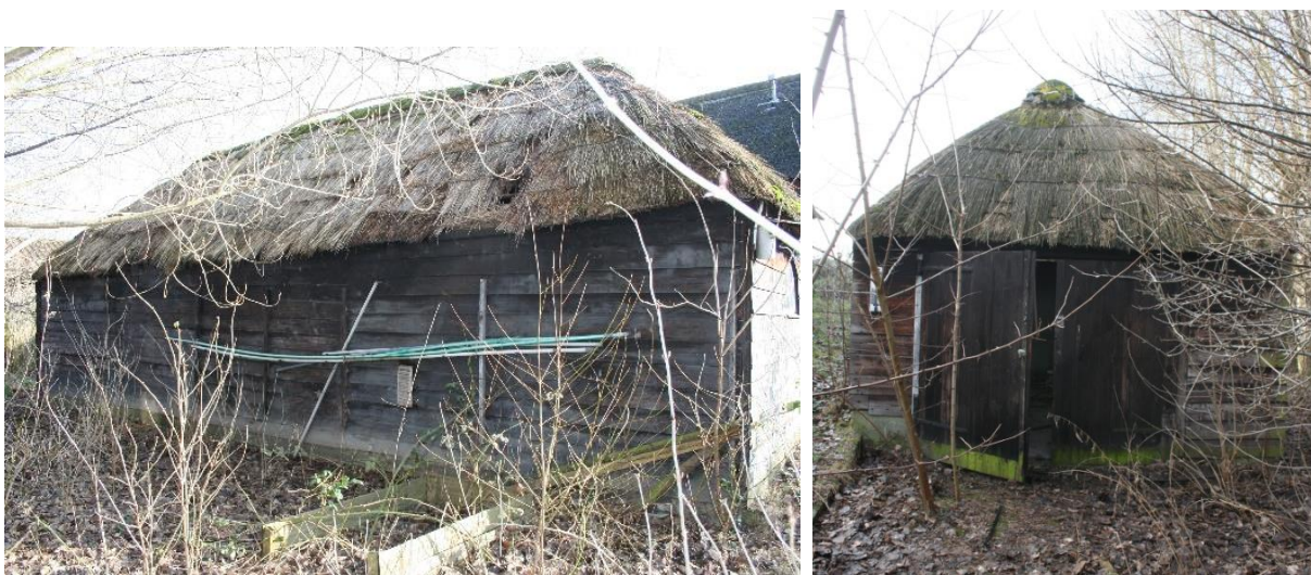
Figuur 21 Links: de westgevel van bijgebouw 2, rechts: de noordgevel.
