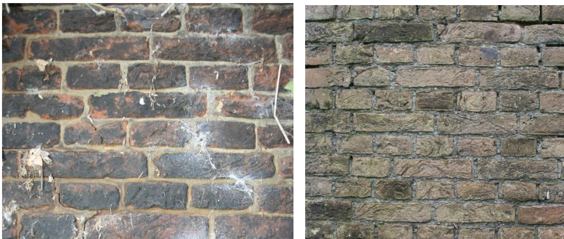
Figuur 16 Links de orangerode bakstenen in de noordgevel. Rechts de IJsselsteentjes.
