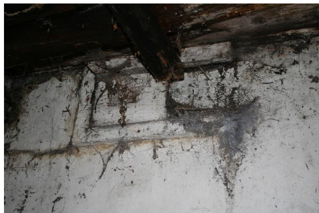
Figuur 11 Links een ventilatie-opening in de zuidgevel. Rechts één van de schuiven waarmee de ventilatie geregeld werd.
