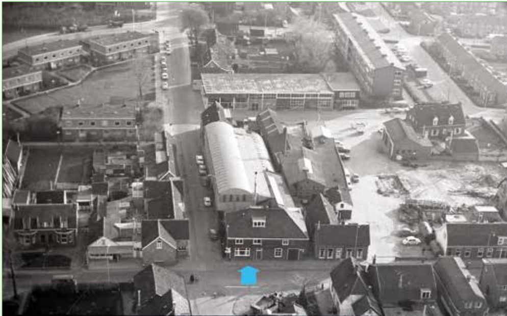
Den Hoorn 29 hoek Rokkeveenseweg met de constructiewerkplaats van Van Driel in 1968 (foto M.C. van Hoeven)
