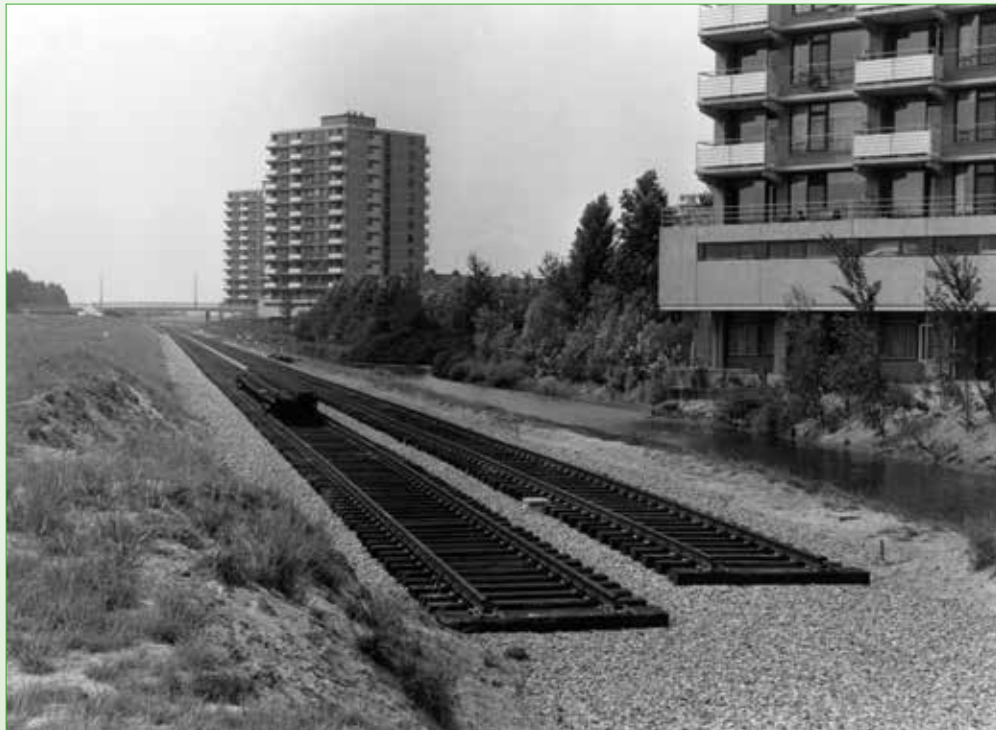
Aanleg van het spoor tussen de toekomstige stations Dorp en Delftsewallen, 1975-1977
