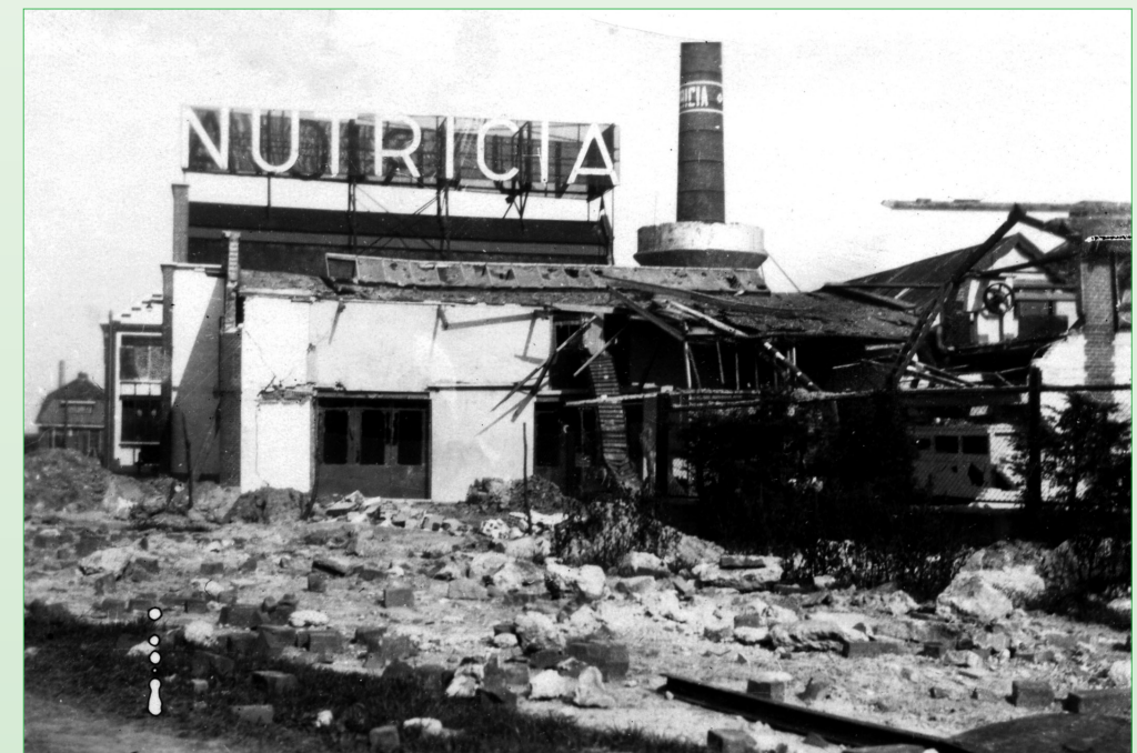
De fabriek van Nutricia is op 30 maart 1945 zwaar beschadigd door een bom, bedoeld om het spoor onbruikbaar te maken
