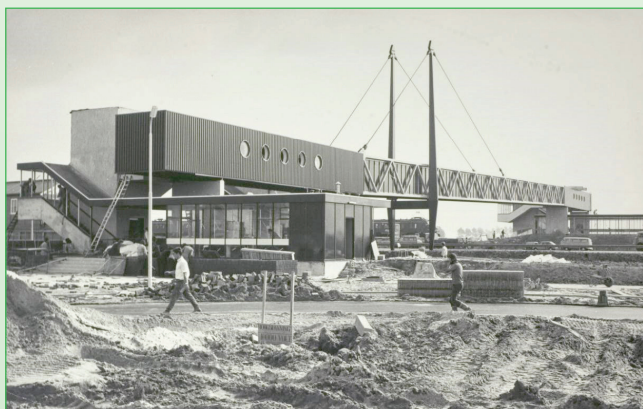
De loopbrug van het dubbelstation in aanbouw, 1973
