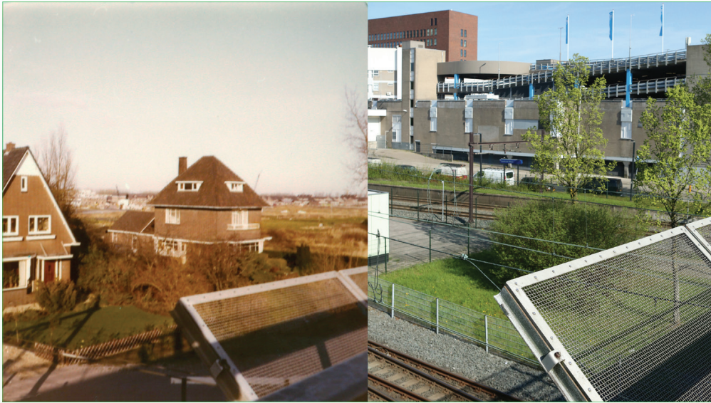
Villa Franx en de huidige situatie aan het Bovenlang
