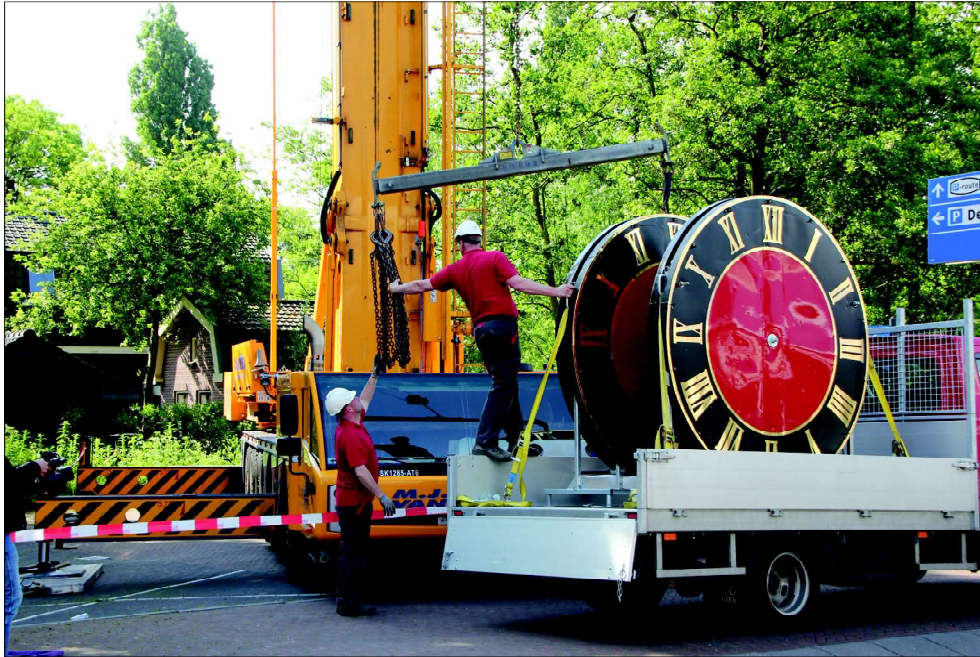
Tijdens de restauratie van de toren afgelopen zomer zijn ook de wijzerborden geschilderd en verguld (foto A. Hoogland)
