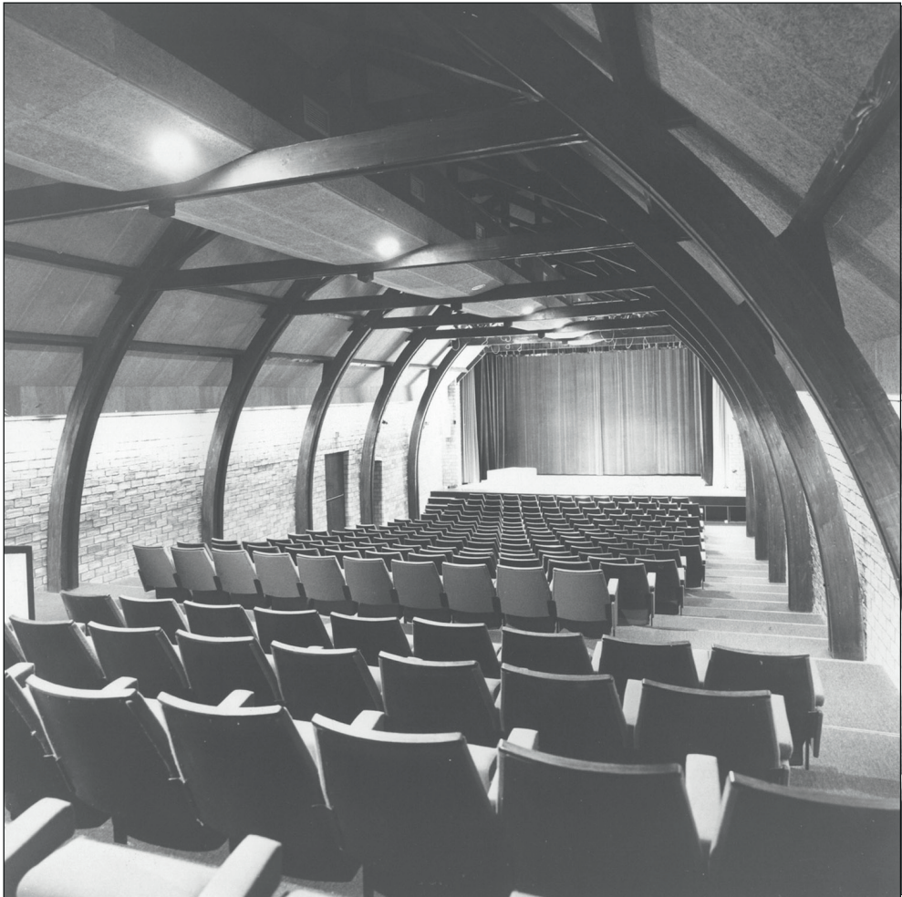
De zaal met het toneel in de Graanschuur, 1977 (foto Kees van der Burg)
