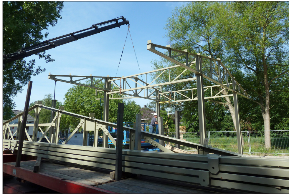
Twee van de oude spanten zijn op 25 juni 2015 geplaatst boven het nieuwe podium op het Nicolaasplein, de derde ligt nog op de vrachtwagen. (Foto Ton Vermeulen)
