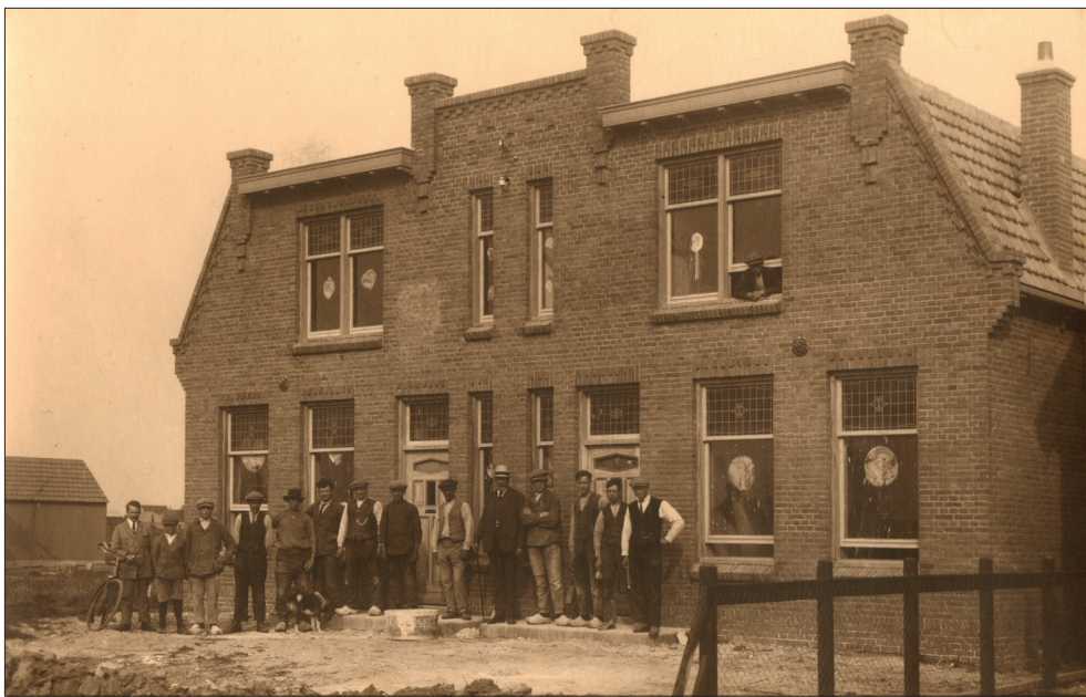
Stationsstraat 112-114 in aanbouw in 1925. (Collectie C. Kraal)
