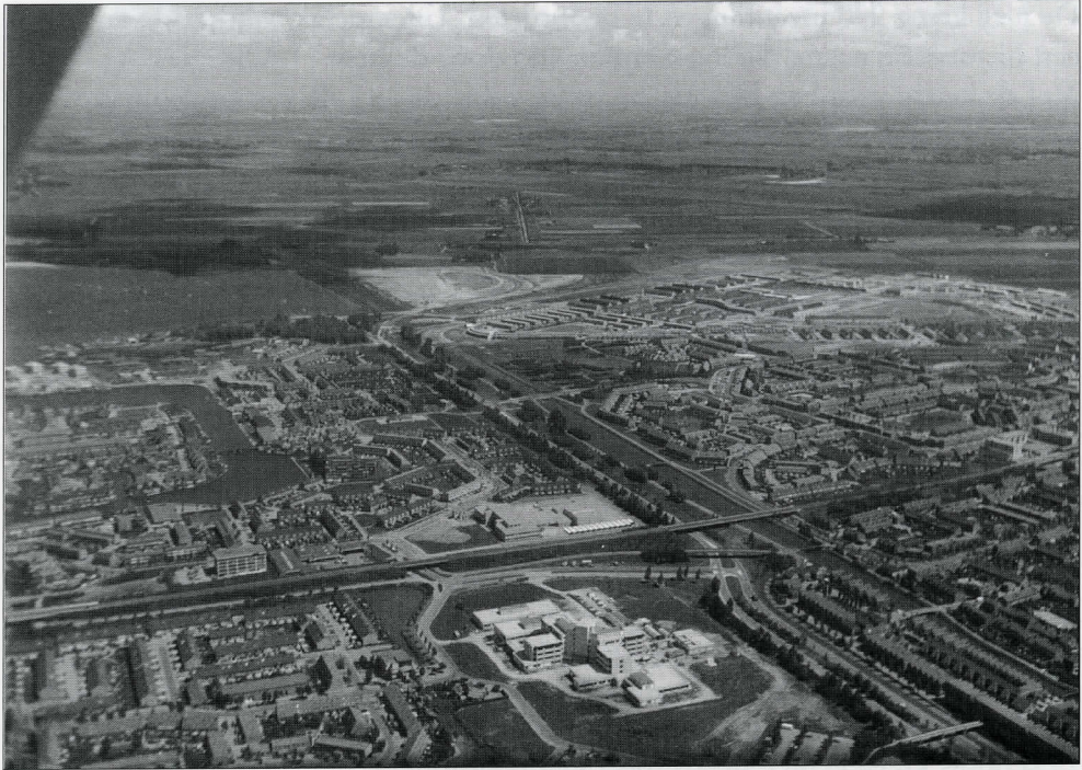
Het ziekenhuis in aanbouw temidden van de woningen van de wijken De Leyens en Seghwaert, 1987 (foto P.J.M. van Domburg)
