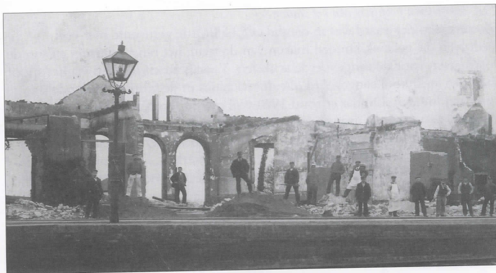
De ravage na de brand, op 4 februari 1905, was groot
