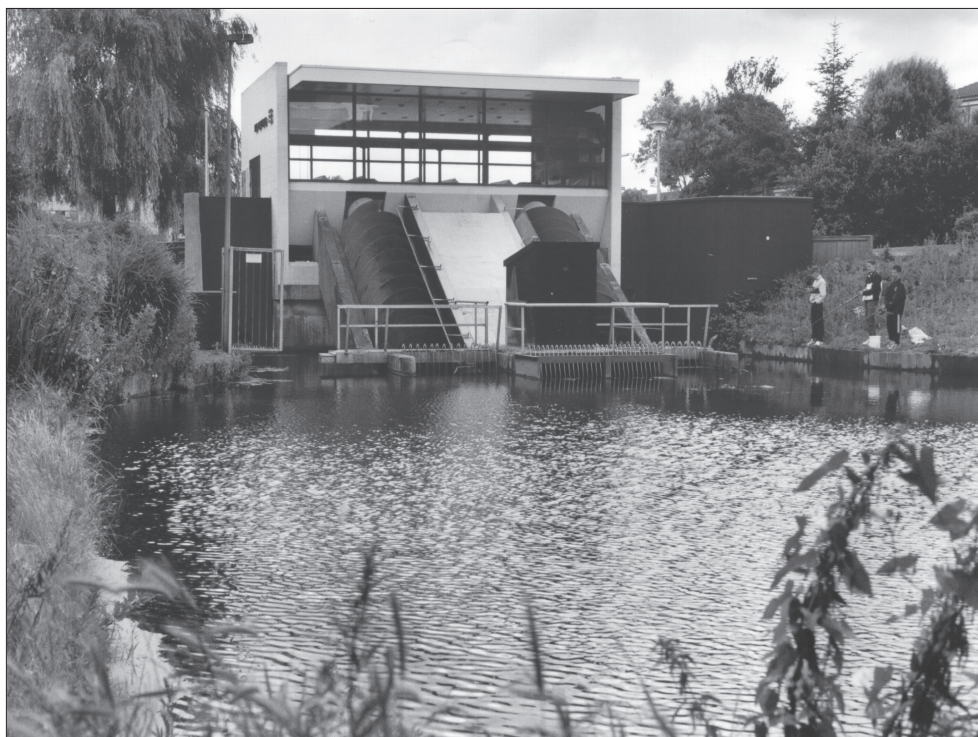
Het gemaal De Leyens, nabij de Kadelaan (foto Aat Hoogland)
