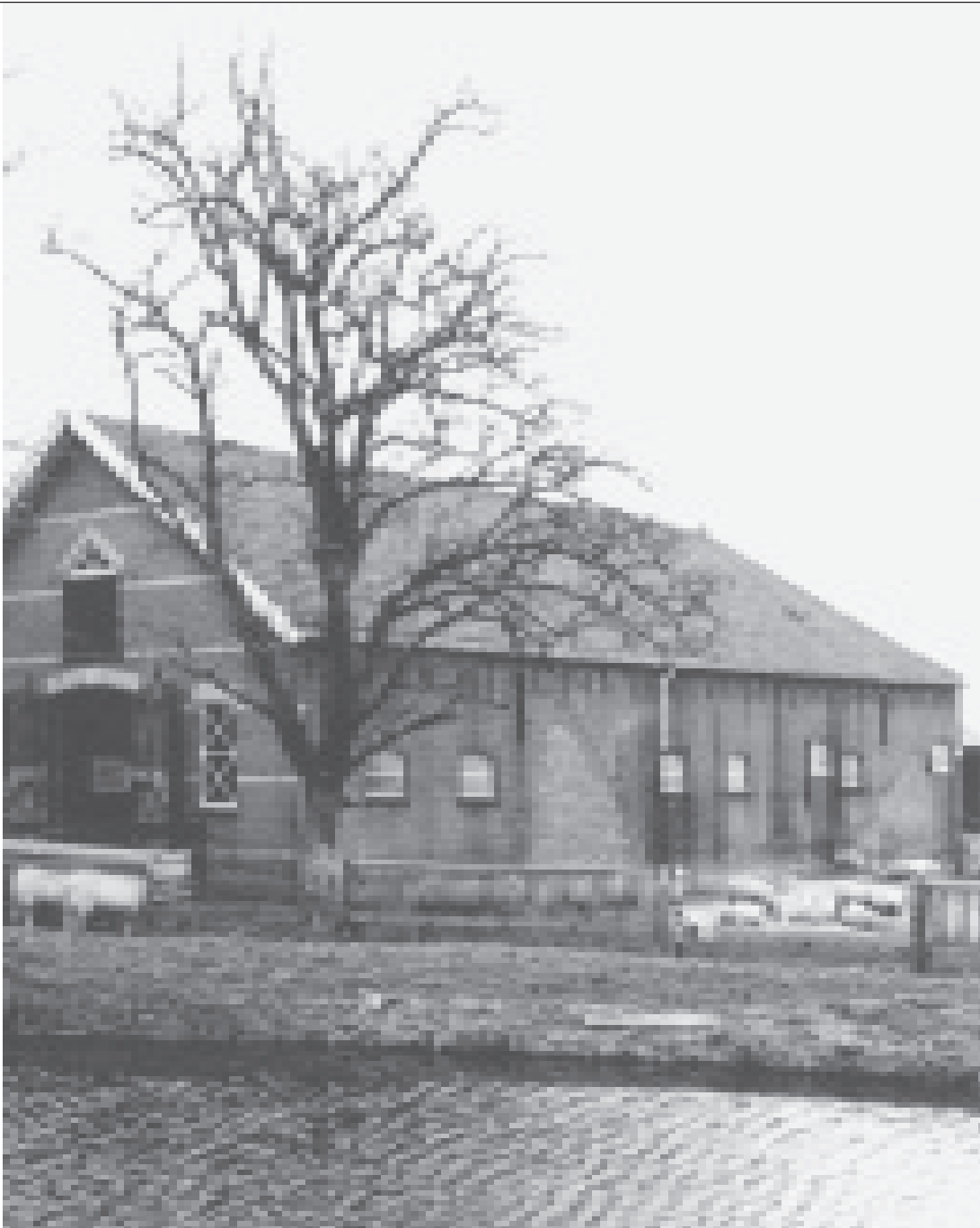
Deze boerderij is afgebroken in 1992. Tegenwoordig is op deze plaats het tuincentrum Intratuin gevestigd. katholieke schuurkerk opgegraven.
