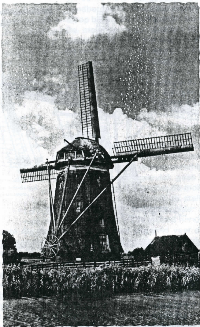
Op deze foto van de ondermolen van de Driemanspolder tussen Zoetermeer en Leidschendam is goed te zien dat de roeden gestroomlijnd zijn volgens het systeem van molenaar Dekker te Hazerswoude. Eind jaren '50 is bij restauratie het Dekkersysteem weer verwijderd.
