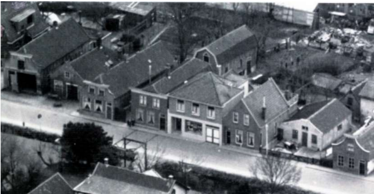
Vlamingstraat 19-21-23-25-27-29, 31 (schuur) en 33 (halsgevel)
