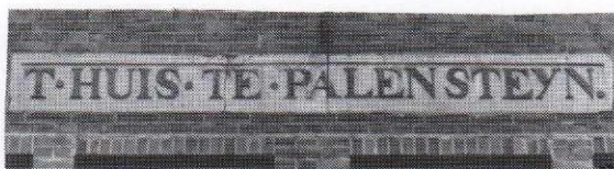
Figuur 3.4. De gevelsteen van Palenstein in de muur van de Brinkersfabriek.
