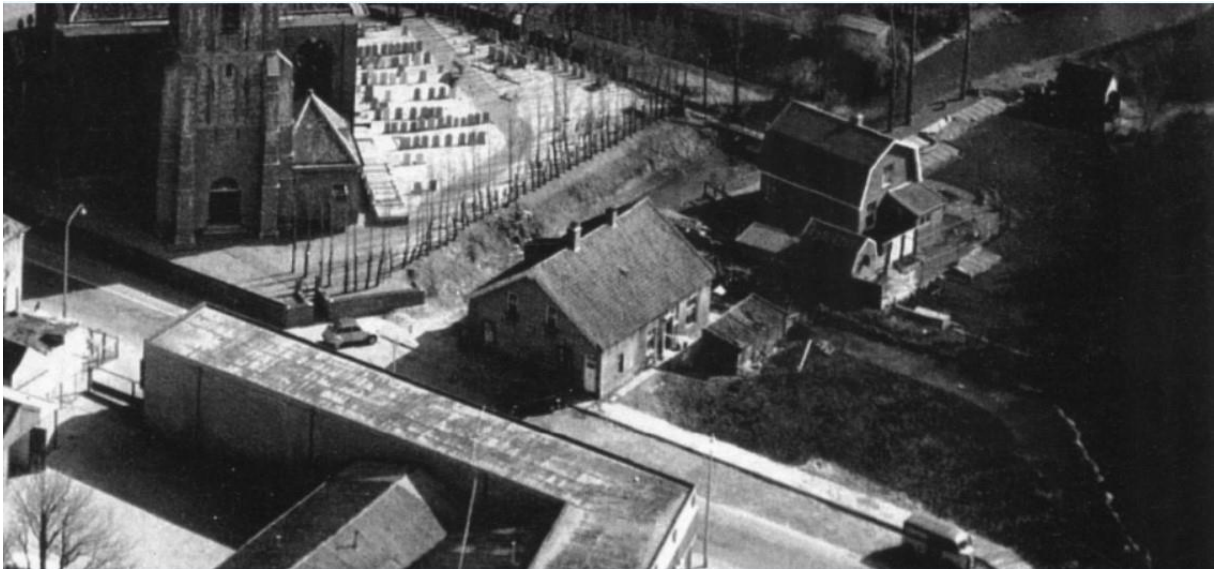
Delftsewallen 7-9 vlak voor de sloop, ca. 1967. Tussen dit blokje en de kerk is de Buurvaart in 1953 gedempt. De nieuwe verbinding Delftsewallenwetering-Buurvaart loopt tussen het blokje en de kosterswoning (rechts) door.
