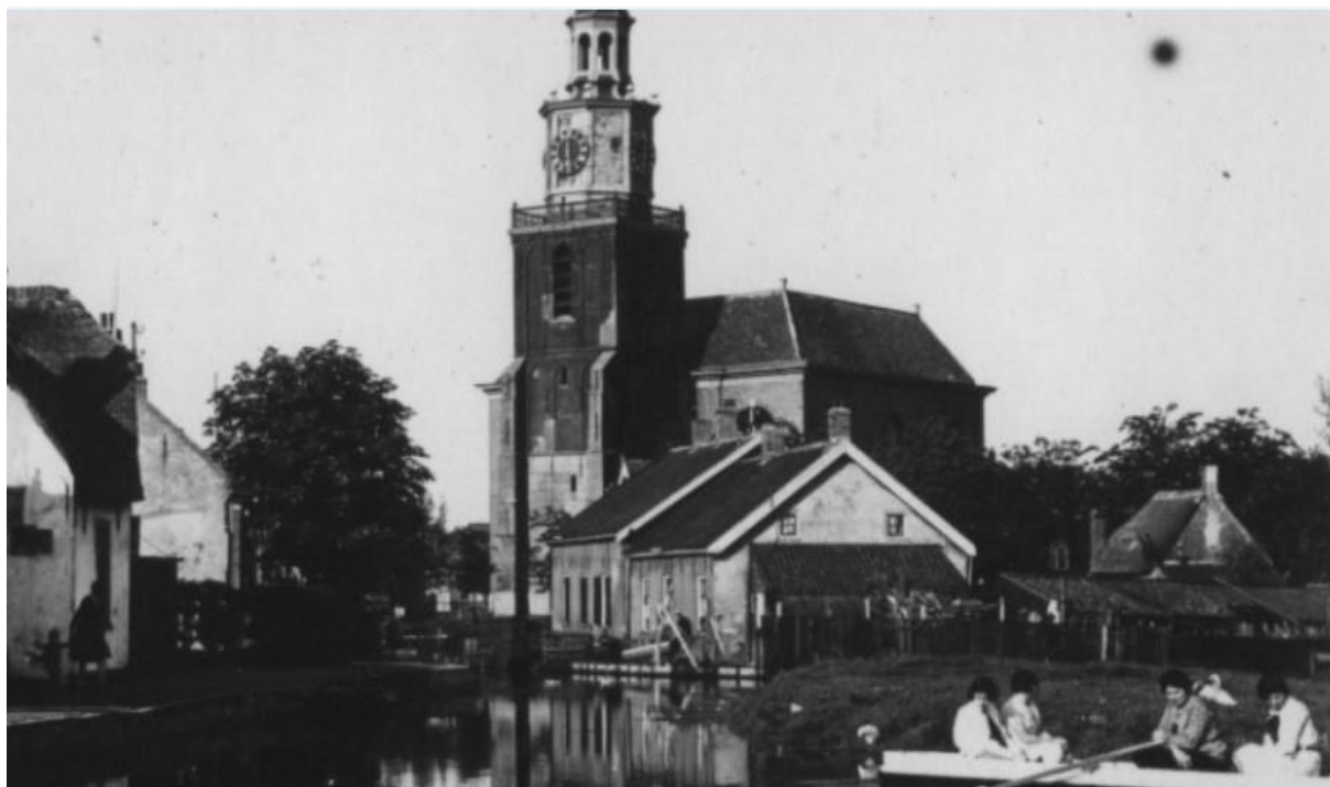
Rechts staan de lage schuren van de Negen huisjes. Het schuine dak daarachter is van de kosterwoning vóór de herbouw in 1932.
