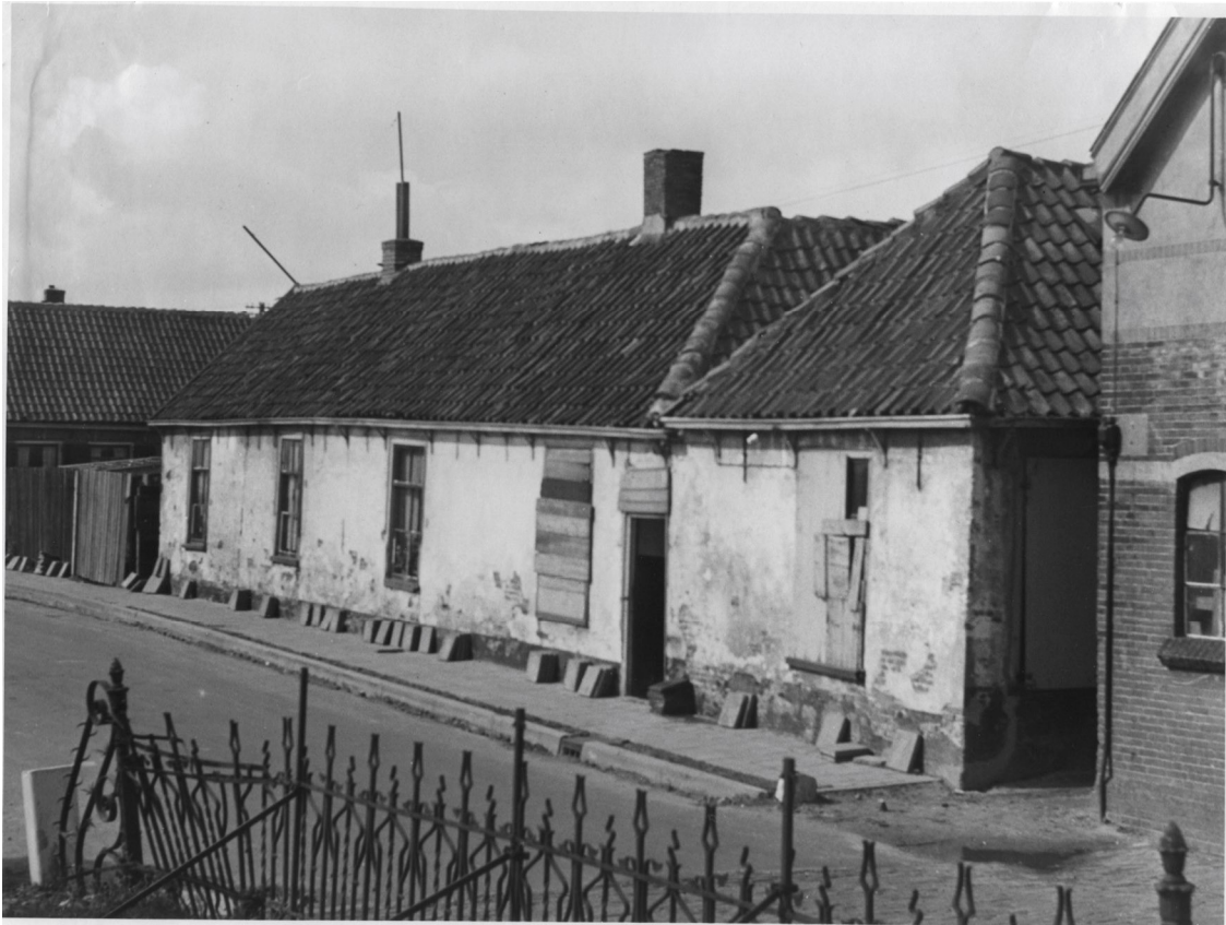
Delftsewallen 21-24 vlak voor de sloop, 1955. Rechts nog een klein stukje werkplaats nr. 25.
