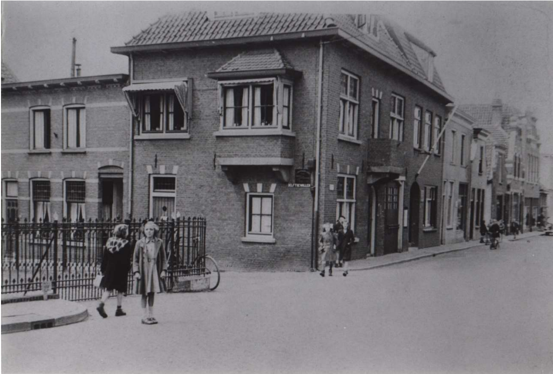
Het nieuwe pand Dorpsstraat 57, gebouwd 1935. Links Delftsewallen (29-30).
