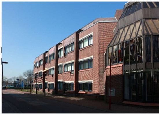
Verspringende gevel en strakke raampartijen
