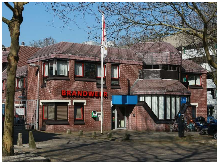
Figuur 9 Verspringende gevel en ingang brandweer
