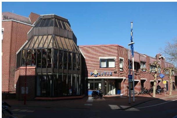
Figuur 7 Kegelvormige ingang politiebureau
