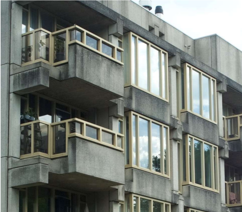
Figuur 10: Details: zichtbaarheid van de hoofdstructuur, prefab balkon- en gevelelementen, hier bij het appartementengebouw 3, juni 2019 (foto Sipkes)
